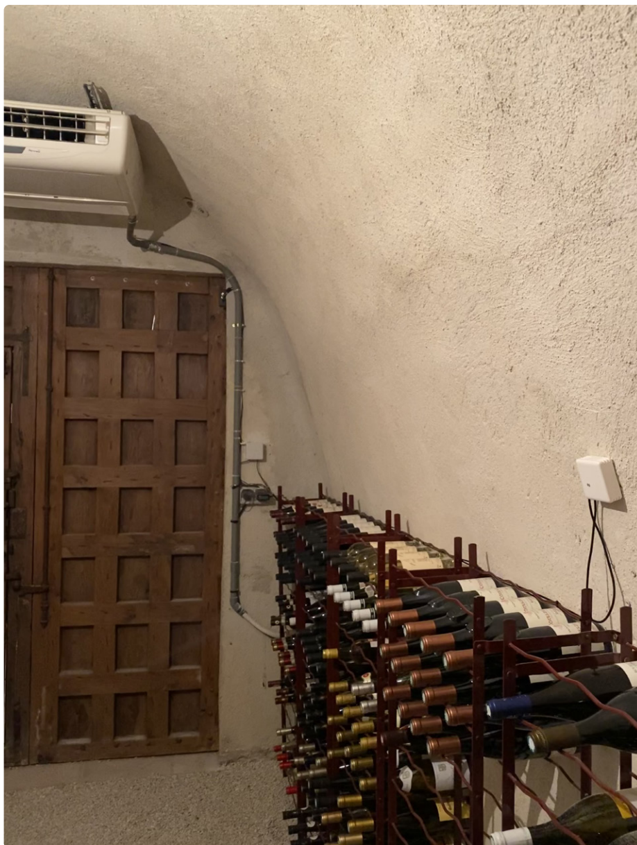
Figure 9. Le capteur DS18B20 a été monté dans une petite boîte en plastique séparée, fixée à un endroit stratégique de la cave. Un deuxième capteur, identique, transmet la température à mon système de domotique via un module spécifique. Cela ajoute une redondance de sécurité au cas où le thermostat tomberait en panne. Si cela se produit, mon système de domotique me prévient.
