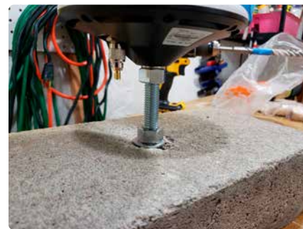
Figure 6. Fixation de la base de l'antenne sur le filetage de l'ancrage.
