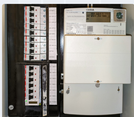
Figure 7. L'unité consommatrice équipée d'un disjoncteur supplémentaire de 10 A (au centre à gauche) et d'un petit compteur électrique (en bas à gauche). Le compteur moderne à droite comporte un blocage anti-retour.
