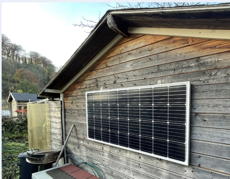
Figure 2. Le panneau solaire 12 V monté verticalement sur le mur de l'abri de Klaus. Il a une puissance de 180 Wc.
