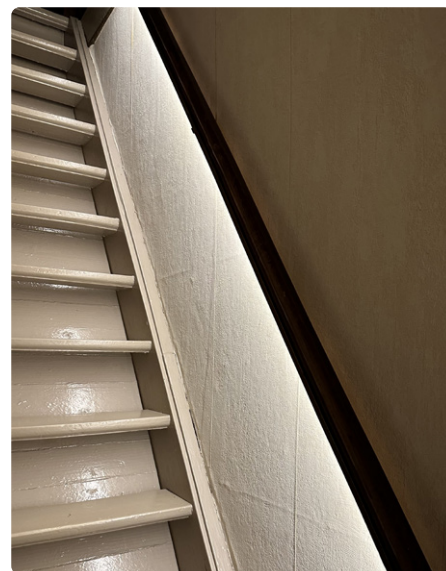
Figure 1. L'auteur a utilisé le circuit décrit dans cet article pour éclairer un escalier en toute sécurité. La lumière ne doit en aucun cas s'éteindre lorsque quelqu'un se trouve dans l'escalier. La bande de LED est montée sous la rampe et éclaire les marches. Le capteur est placé en haut de l'escalier, de sorte que toutes les marches sont à portée du radar.
