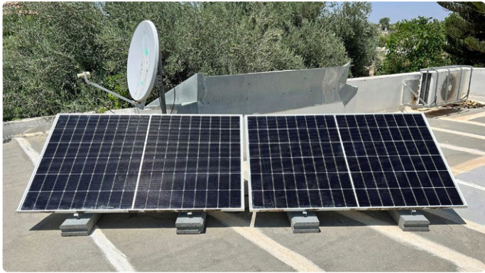
Figure 8. Installation d'une centrale sur balcon sur un toit plat avec des pierres en béton.
