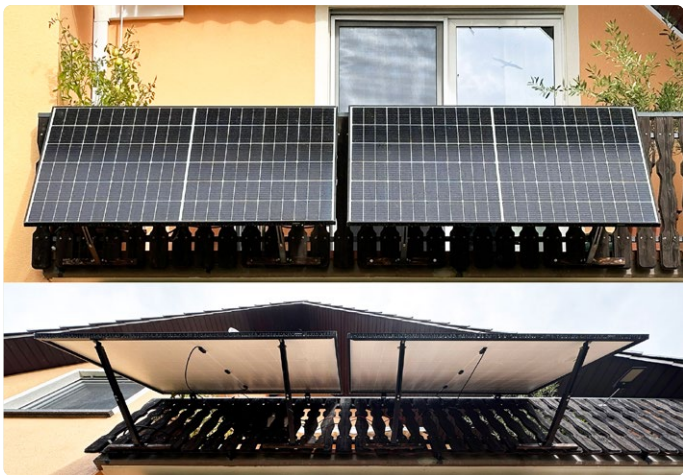
Figure 9. Les panneaux ont été vissés aux planches d'un balcon avec des fixations prêtes à l'emploi en aluminium anodisé noir.
