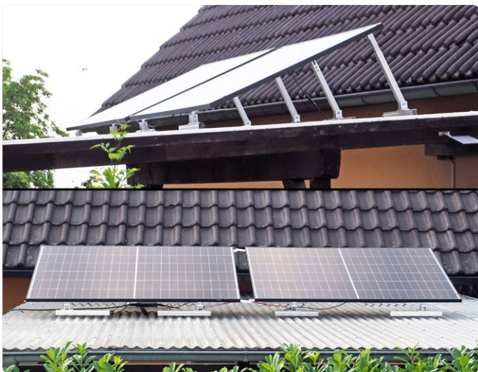
Figure 10. Avec le même système de fixation que dans la figure 9 (ici en aluminium naturel), les modules solaires peuvent également être montés de manière stable sur des toits plats avec un angle réglable.
