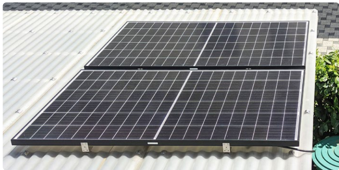
Figure 2. Les deux panneaux de 330 Wc de ma première centrale sur balcon installés sur un auvent.
