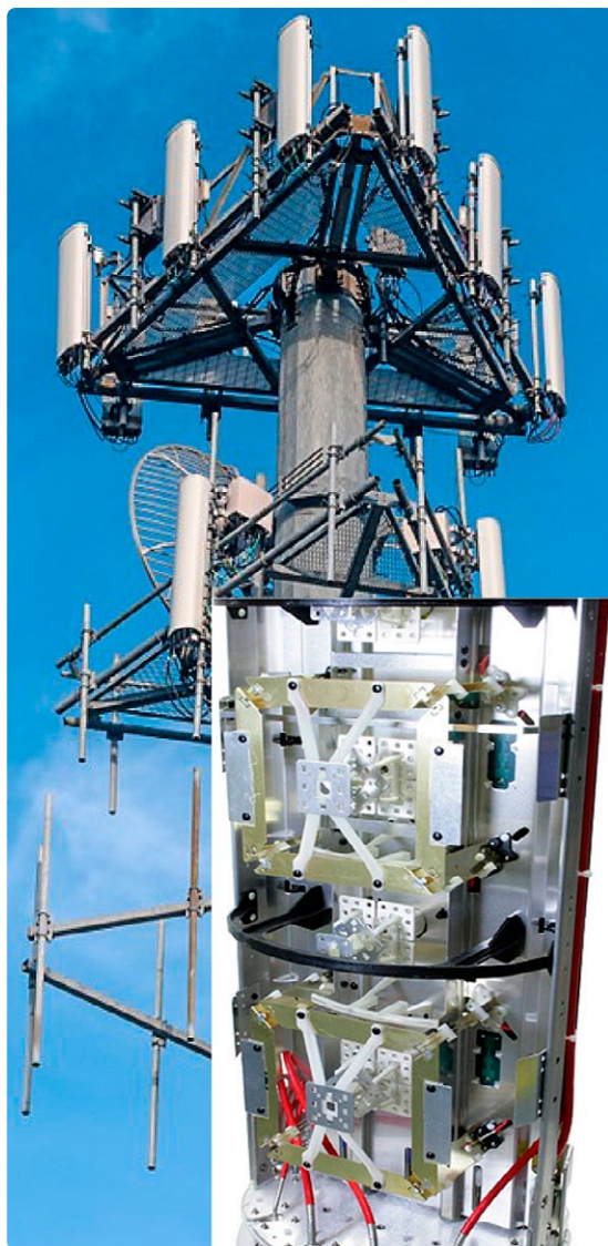
► Figure 2. Une tour 4G (5G) typique pour les bandes 700 MHz et 1 800 MHz, avec une vue détaillée de l'intérieur d'un réflecteur.
