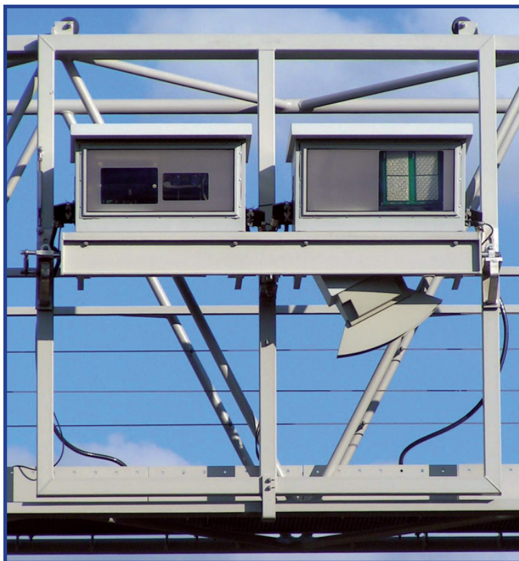
Figure 3. Little Brother is already watching you : les caméras et ordinateurs montés sur les portiques de péage des autoroutes allemandes sont en mesure, actuellement déjà, de reconnaître les véhicules. Photo avec l'aimable permission de Stefan Hühn ( www.webkuehn.de ).
