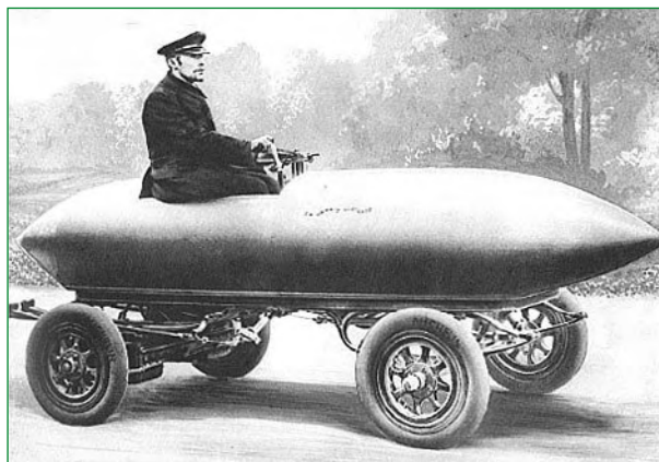
Figure 1. Retour au futur : il y a 112 ans, l'auto électrique était insurpassable. Camille Jenatton atteignit 105,8 km/h en 1889 avec des batteries au plomb de 50 kW.
