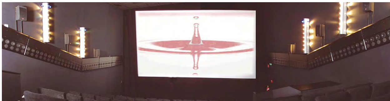
Figure 12. Installation de synthèse de front d'onde du cinéma « Linden Lichtspiele » à Ilmenau (Allemagne). Le système dispose de plus de 192 canaux (Photo : IDMT Fraunhofer/Ingo Herzog).
