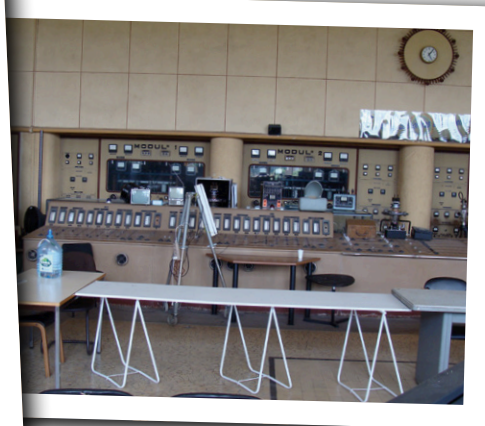
Photo 13. Partie émission du bâtiment B. En 1972 l'ORTF inaugure ses émetteurs de 500 kW, au nombre de huit, associés à un champ d'antennes en Y. Les champs d'antennes sont disposés en forme d'Y afin d'obtenir une diffusion mondiale.
